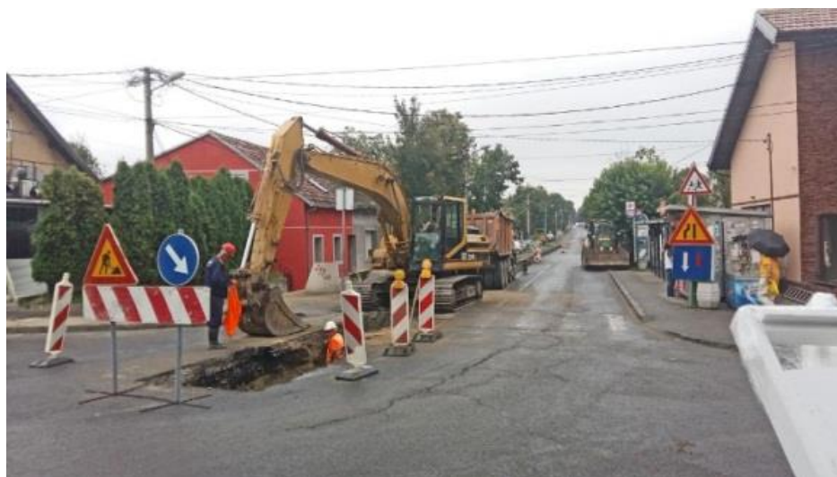
Слика бр. 11: Изградња канализационе мреже
